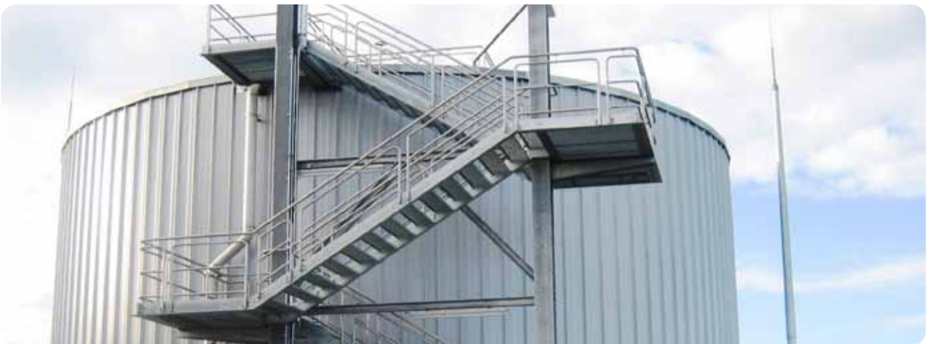
Faulbehälter Hochland Deutschland GmbH in Schongau: Verkleidung Neubau Faulbehälter, Besonderheit: gebogene Tragprofile
